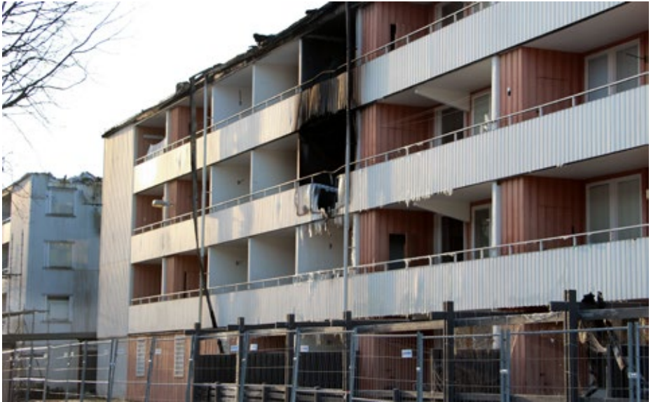
"Skadebesiktning pågår", skriver Sandra Nilsson som är marknadsansvarig på Fastighets AB Balder och som förvaltar de eldhärjade fastigheterna.
