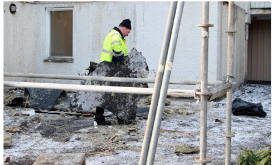
På måndagen pågick det röjnings- och saneringsarbete av de eldhärjade fastigheterna i Södra Ryd.
